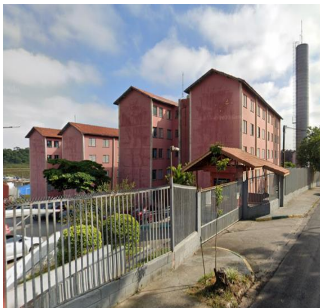
Imóvel localizado na rua Rolândia, Jardim Paranaíba, em Mauá
