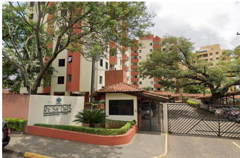
Figura 2 - Imóvel localizado na rua Doutor Gonzaga Machado, Vila Engler, em Bauru
